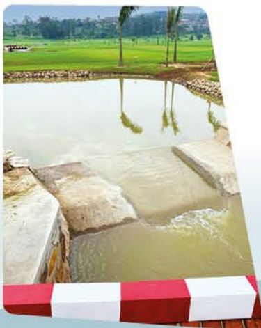
Ouvrage hydraulique pour la gestion des eaux Golf de Kigali - Rwanda
