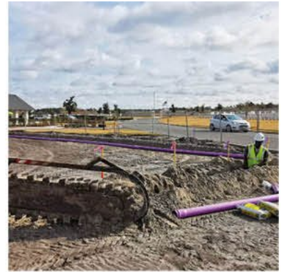
Travaux de VRD - Jacksonville - USA
