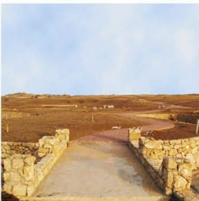
Constructions maçonnées - cheminement golf - Maroc
