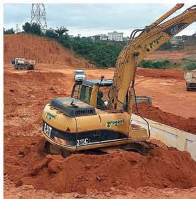
Travaux de terrassement - Abidjan - Côte d'Ivoire
