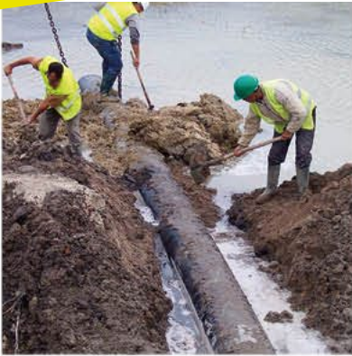
Travaux hydrauliques - Tanger - Maroc
